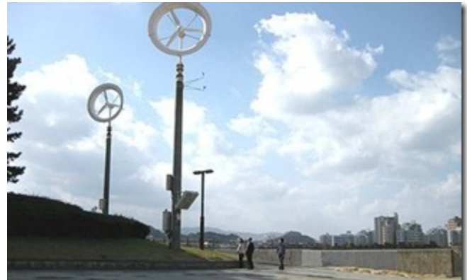
「風レンズ風車」一基当り600～700万円、発電能力3kw。騒音や低周波、バードストライク(鳥が激突する)等の問題がないといわれていますが、汎用化にはコストダウン等の課題が。=11月12日、福岡市シーサイトももち海浜公園
