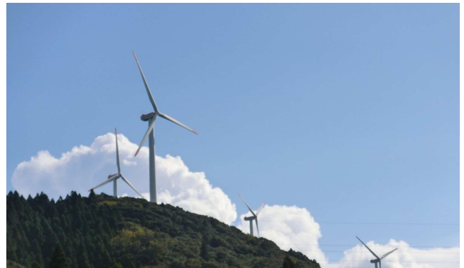
風車には、60mの柱に一辺が30mの羽が3つ。風力3mから発電し、風速25mで自動停止。風力にかかわらず回転速度は一定。=11月13日、鹿児島市牟礼ヶ岡ウィンドファーム
